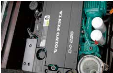
Gut gekapselt, aber auch gut zugänglich ist der Motor.
